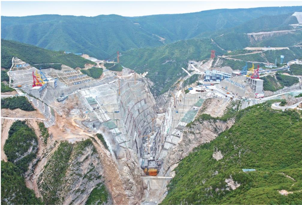
7月7日,航拍建设中的东庄水利枢纽工程。截至目前,东庄水利枢纽工程砂石料加工系统和混凝土拌和系统全部投入运行,具备生产安
