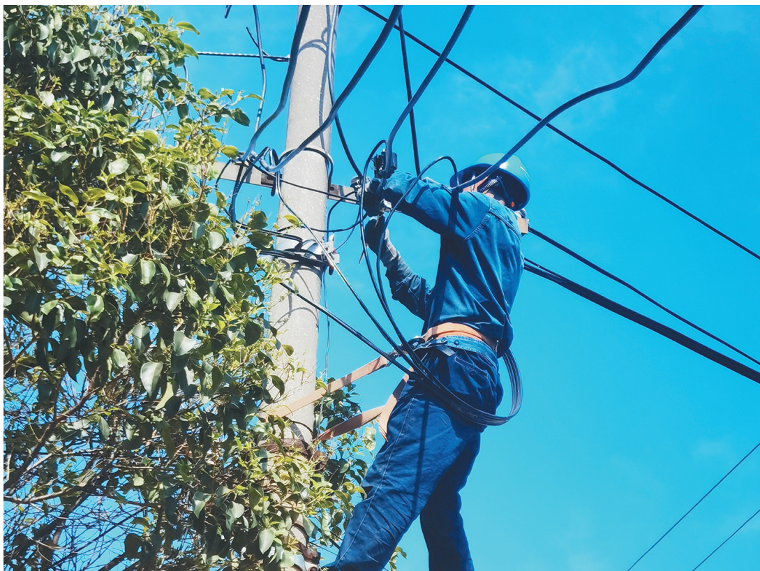
7月10日，国网西安供电公司员工赵伟冒着高温，在秦陵街办西杨村更换绝缘导线，及时满足西杨村165户客户用电需求，助力该地区农家乐、民宿及商铺的正常用电，也为迎峰度夏安全用电提供保障。 □潘世策 摄
