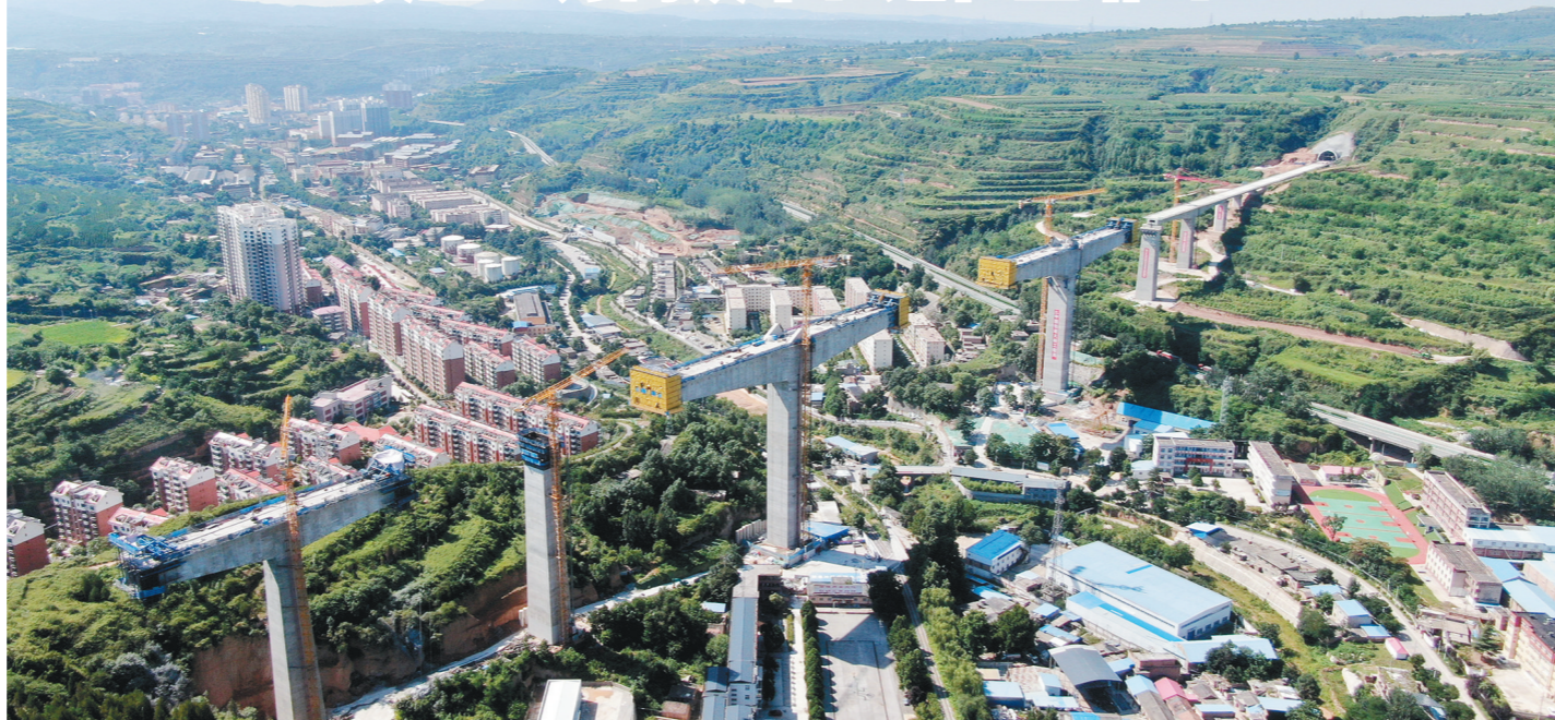
这是位于铜川市王益区的西延高铁王家河特大桥(7月22日摄,无人机照片)。 盛夏时节,在黄土高原地区连绵的山岭之间,西安至延安高速铁路正在紧张建设中。西延高铁是陕北革命老区首条高速铁路。项目建成后,西安至延安铁路运行时间将从目前2个半小时缩短
