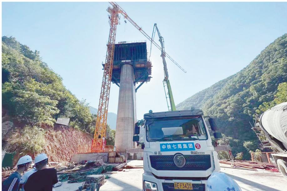
7月17日13时30分，经过近20小时连续浇筑，由中铁七局承建的陕西省重点项目建设西康高铁三标项目北关黄河大桥1号墩0#块顺利浇筑成功，为全标段工程按期完工和全线顺利通车奠定了坚实基础。据悉，北关黄河大桥所处地为南秦岭中山区，地面高程约814至864米，相对高差约50米，地质复杂，施工场地狭小，施工干扰和施工难度非常大。 □余立 摄
