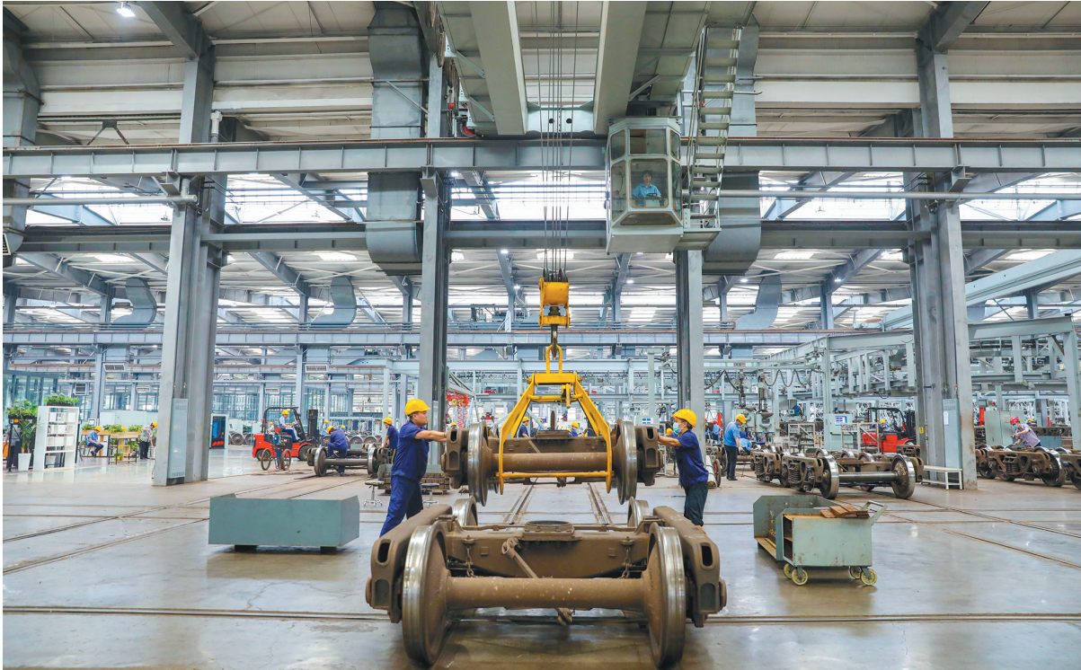
连日来,高温天气持续,国铁西安局西安东车辆段结合车辆季季节性风险,严把检修质量,加大对车辆走行部、制动装置、钩缓装置的检查检修力度,及时消除车辆隐患,确保暑期铁路货车安全平稳运行。图为该段修车车间职工正在吊运货车转向架。
