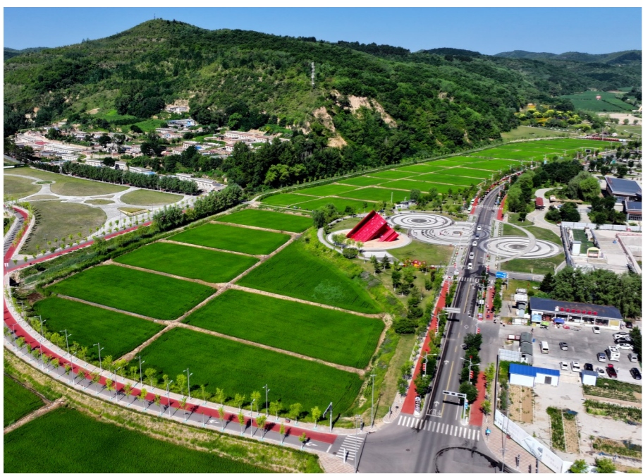
近年来,延安南泥湾经过河道疏浚、岸坡防护、水系连通、水土保持等系统工程,为当地红色文化、休闲旅游、现代农业的深度融合夯实了根基。
