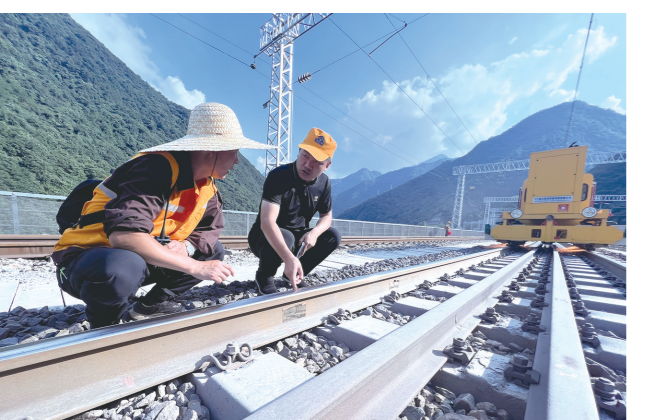
8月15日,国铁西安局安康工务段技术人员对新引进GMC-12 II型钢轨打磨车打磨后的钢轨进行检查。 今年以来,该段围绕运输提质增能创效,以提升线路设备质量为重点,加大养路新设备新技术的投入力度。 张霖 摄
