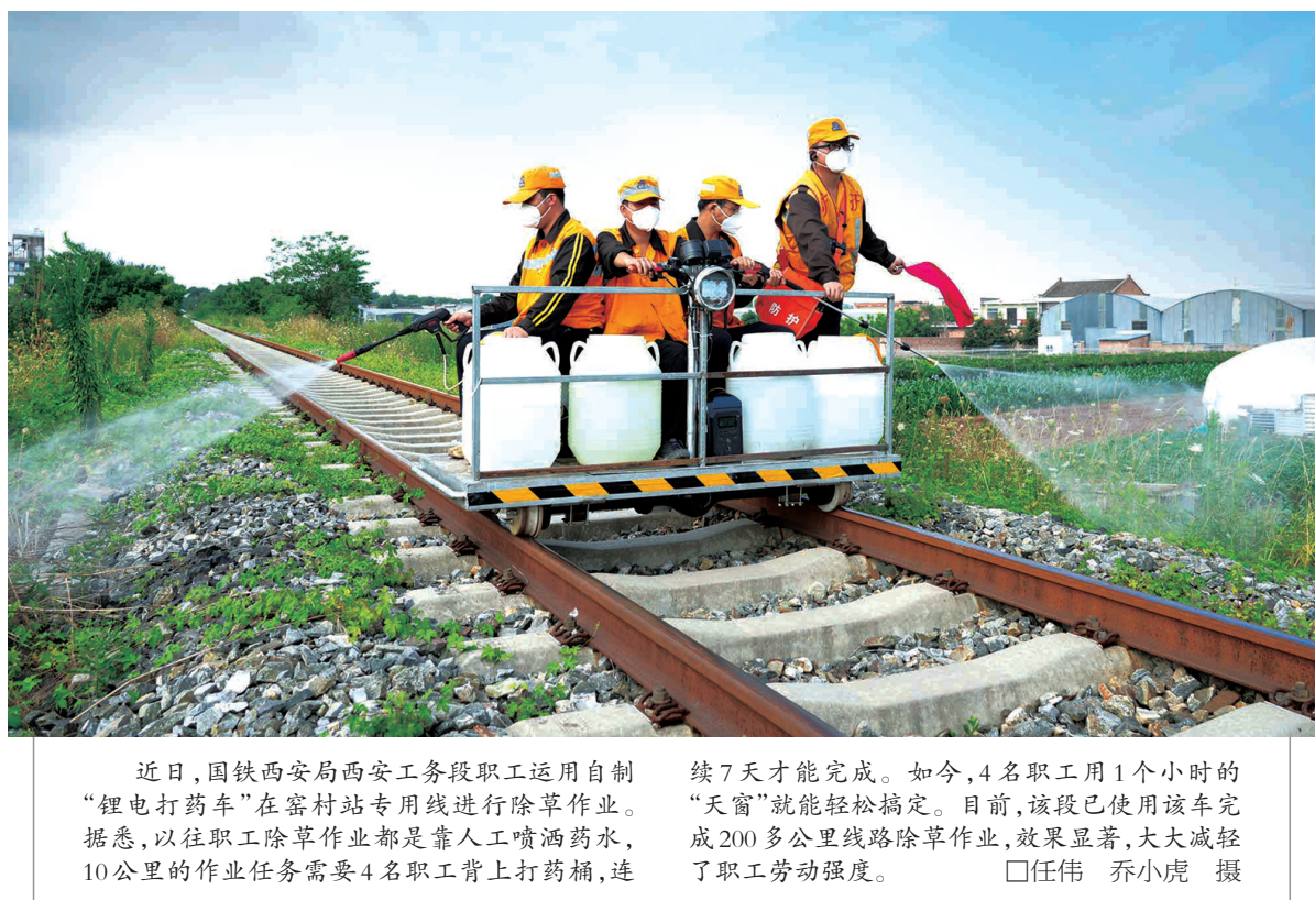
近日,国铁西安局西安工务段职工运用自制“锂电打药车”在窑村站专用线进行除草作业。据悉,以往职工除草作业都是靠人工喷洒药水,10公里的作业任务需要4名职工背上打药桶,连续7天才能完成。如今,4名职工用1个小时的“天窗”就能轻松搞定。目前,该段已使用该车完成200多公里线路除草作业,效果显著,大大减轻了职工劳动强度。 □任伟 乔小虎 摄
