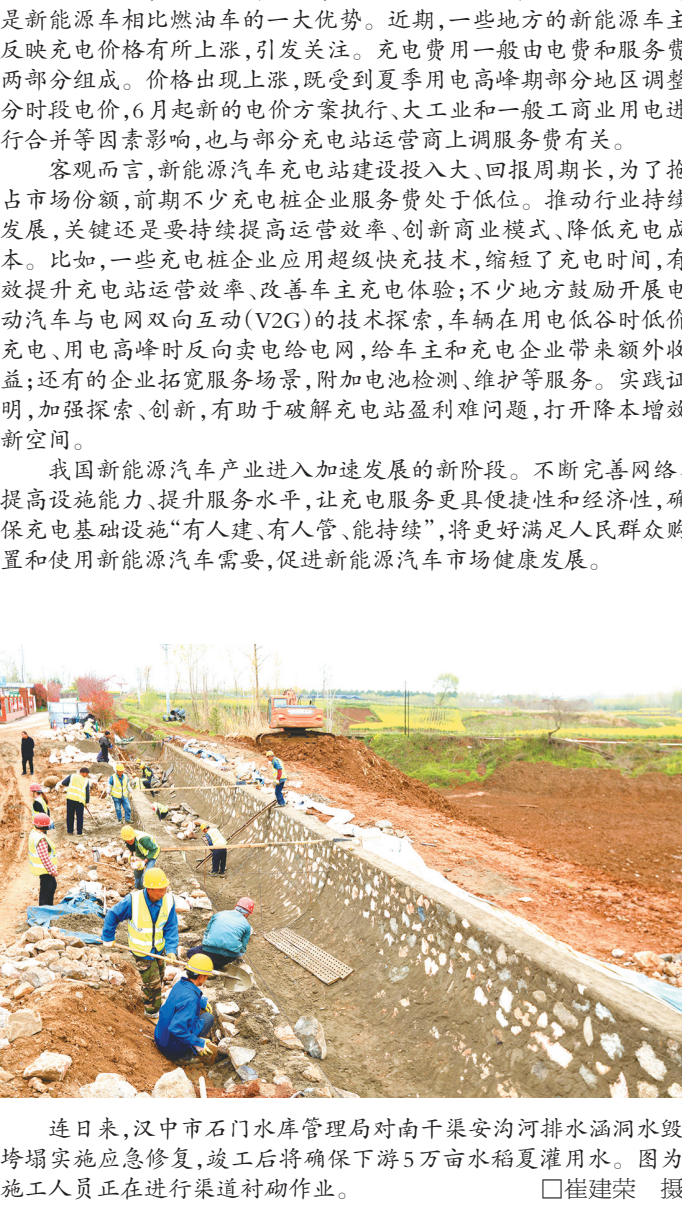
连日来,汉中市石门水库管理局对南干渠安沟河排水涵洞水毁垮塌实施应急修复,竣工后将确保下游5万亩水稻夏灌用水。图为施工人员进行渠道衬砌作业。 □崔建荣 摄
