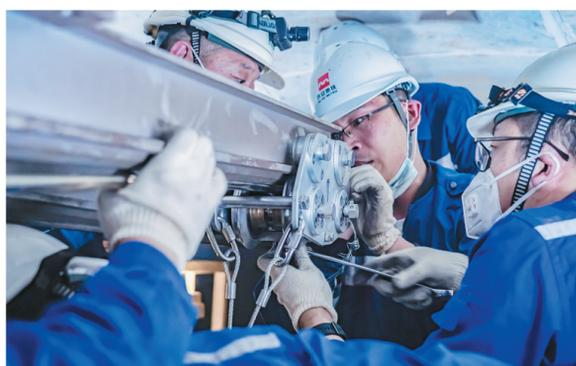
8月29日凌晨,西安市轨道交通集团运营分公司接触网岗位员工在对地铁3号线延平门站-科技路站区间开展刚性接触网换线工作。本次换线作业创新实施“拆放同步”的一体化换线工艺,有效提升了作业施工效率,极大节省了运营维护成本。
