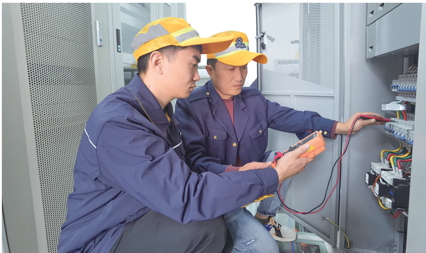
近日,国铁西安局西安通信段汉中西通信车间在标准化通信机房整治中开展结对帮带活动,在实战中促进提高青工业务技能。图为高铁夜莺攻坚队检修铁路通信设备。 □蒋涛 摄
