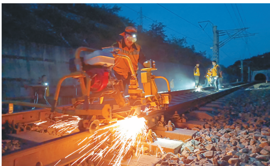
10月28日,西安铁路局延安运营维修段西峡东综合维修车间青年职工在浩吉铁路下行线上用精磨机打磨钢轨,为北煤南运大通道安全畅通提供设备保障。 □赵红伟 摄
