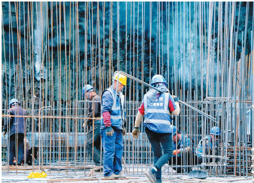
近日,陕建十二建集团安康高新区联合社区项目部抢抓施工黄金期,紧盯目标节点,现场塔吊高耸、长臂挥舞,各工种作业如火如荼。图为工人进行墙体钢筋绑扎施工。□胡家斌 摄
