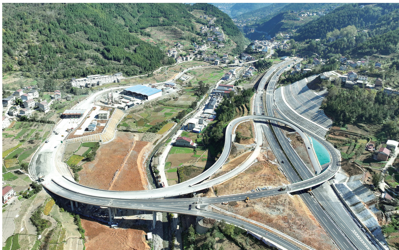
巫镇高速公路中坝互通施工现场(11月1日摄,无人机照片)。巫镇高速公路连接陕西省镇坪县与重庆市巫溪县,全长约48.7公里,总投资98.4亿元,全线桥隧比较高,施工难度大。
