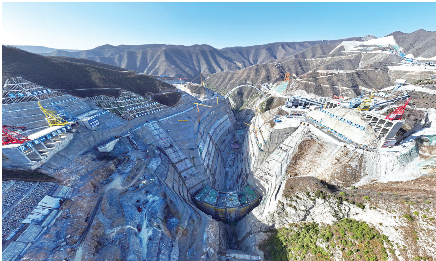
11月23日,航拍建设中的陕西省东庄水利枢纽工程建筑现场。 初冬时节,作为国家172项节水供水重大水利工程之一,该工程建设现场车辆往来穿梭,大坝土建与安装工程有序推进。为确保冬季施工质量安全,东庄水利公司下发最新低温季节温控技术要求,编制冬季施工保温措施方案,从原料储存、加工、运输、混凝土施工保温和实体保温等多环节入手,有力推进低温季节施工进度。 本报记者 鲜康 摄
