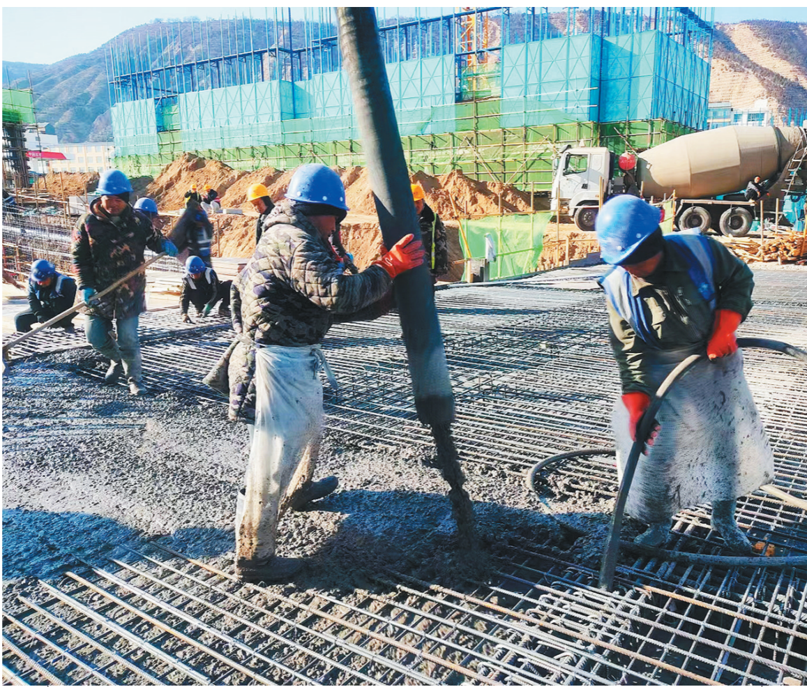
为加快项目建设进度,陕建十二建集团定西未来城项目各工种作业人员紧盯施工节点,确保项目早日建成投入使用。图为11月30日工人进行混凝土浇筑。 □通讯员 胡家赋 摄
