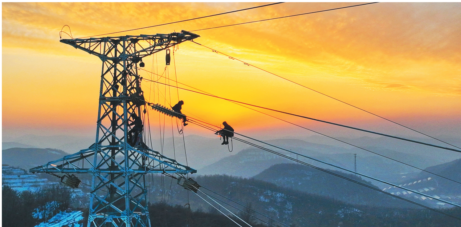
12月12日,延安市安塞区安塞黄矿新能源公司高桥镇200兆瓦光伏产业项目110千伏输电线路布设工作正在进行中。此线路总长15公里,共设39基铁塔,截至目前,已完成37基铁塔基础及组塔施工,放线工作正在进行,完成总工程量的95%。计划本月底前具备投运条件。 通讯员 王栋 摄
