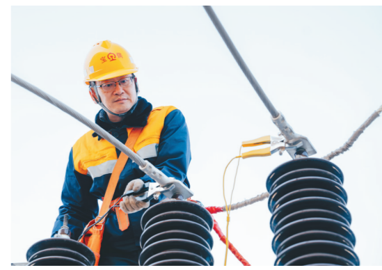
连日来,为有效应对寒潮天气,西安铁路局宝鸡供电段组织干部职工以“动”治“冻”,加强对变电所设备加热装置、充气充气等设备巡视检查,确保设备运行安全。
