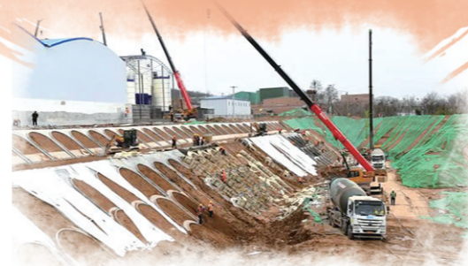
建设中的西安东站。
