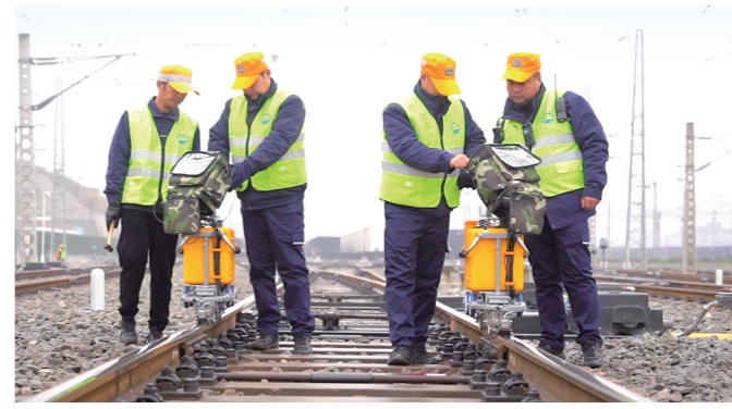
2023年12月29日,西安铁路局安康工务段职工对安康东站编尾道岔区段进行探伤作业。
