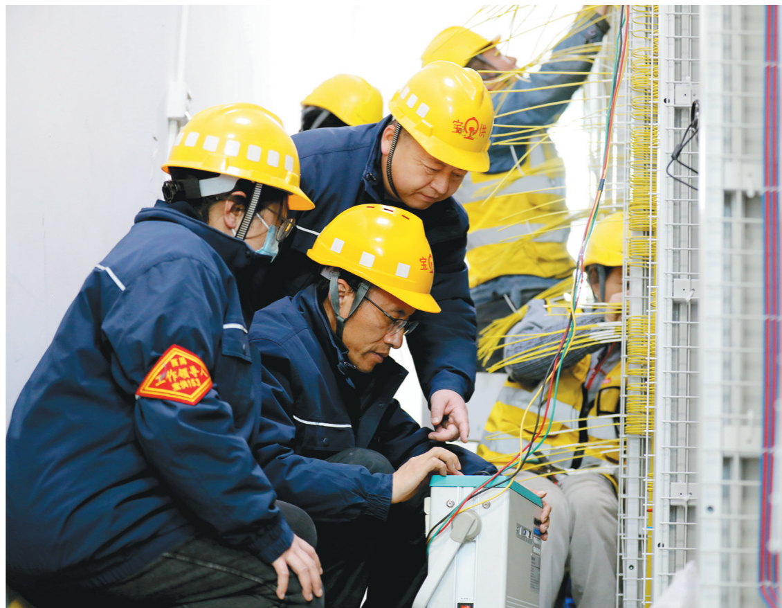
元旦假期期间，国铁西安局宝鸡供电段施工不停，进行观音山变电站设备综合自动化升级改造工作，检修工需完成近万米的电缆敷设与近万个接线端子的连接、校验、调试，以全面保证设备安全施工和投运。
