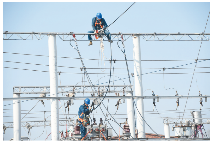
1月8日,国网西安供电临潼公司组织多班职工对35千伏马额变电站进行检修作业,保障群众春节期间安全可靠用电。 □通讯员 潘世策 摄
