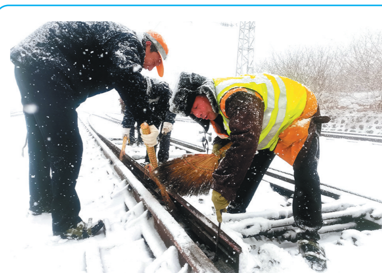
1月15日,关中地区普降大雪,中国铁路西安局集团有限公司阎良工务段组织扫雪除冰小分队,对道岔咽喉等重点区域进行积雪清理,全力确保行车安全。 □通讯员 刘晓瑞 摄
