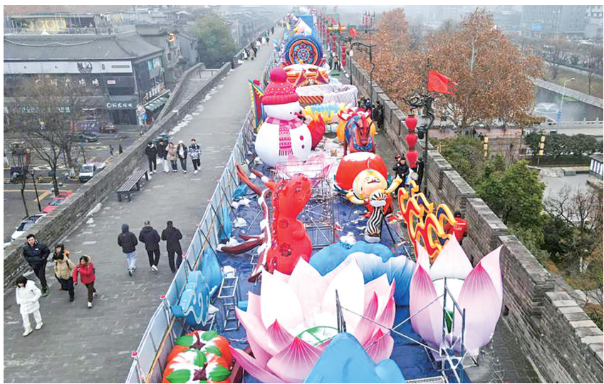
工人正在城墙上制作灯组。
