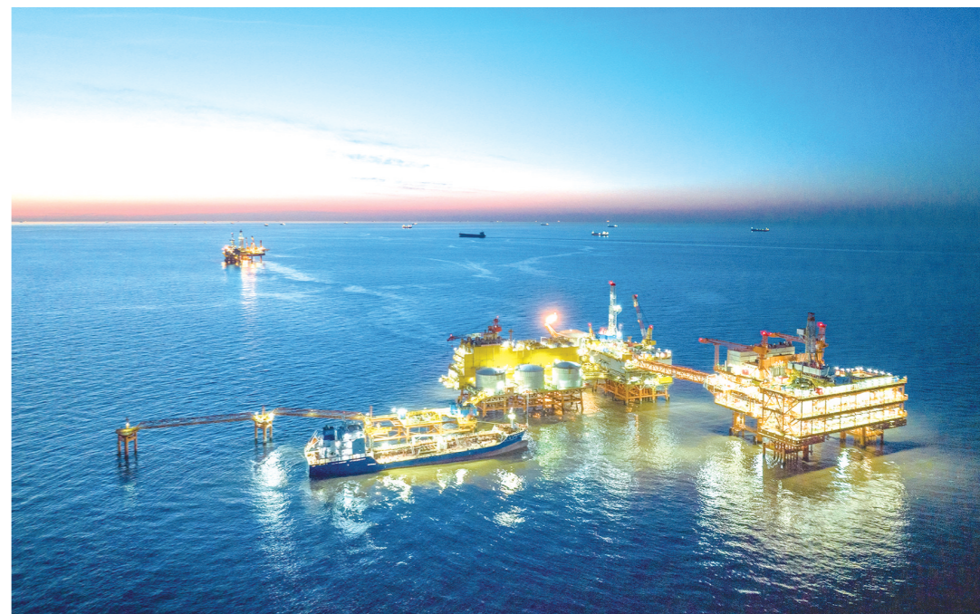
这是1月25日拍摄的埭北油田全景(无人机照片)。当日,位于渤海湾西南部的埭北油田油气处理与岸电设备共建平台——CEPC
