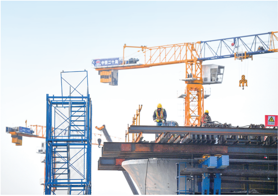
1月25日,中铁二十局工人在位于西安市的西延高铁渭河特大桥施工现场工作。入冬以来,陕西经历多轮冷空气过境,延安地区最低气温一度突破-26℃。在西延高铁沿线施工现场,只见塔吊林立、焊花飞舞、机器轰鸣……建设者筑路老区的脚步依旧。 张博文 摄
