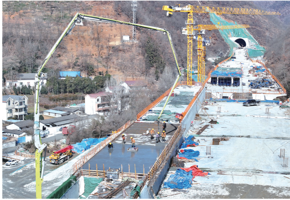
1月26日,工人在中铁十一局集团西康高铁4标段项目施工现场作业。春节临近,西安至安康高速铁路的建设者坚守在工作岗位,加紧推进工程建设。截至目前,西康高铁“路、桥、隧”站前工程累计完成建设投资100.23亿元,占项目建设总投资的54.6%。 邵瑞 摄
