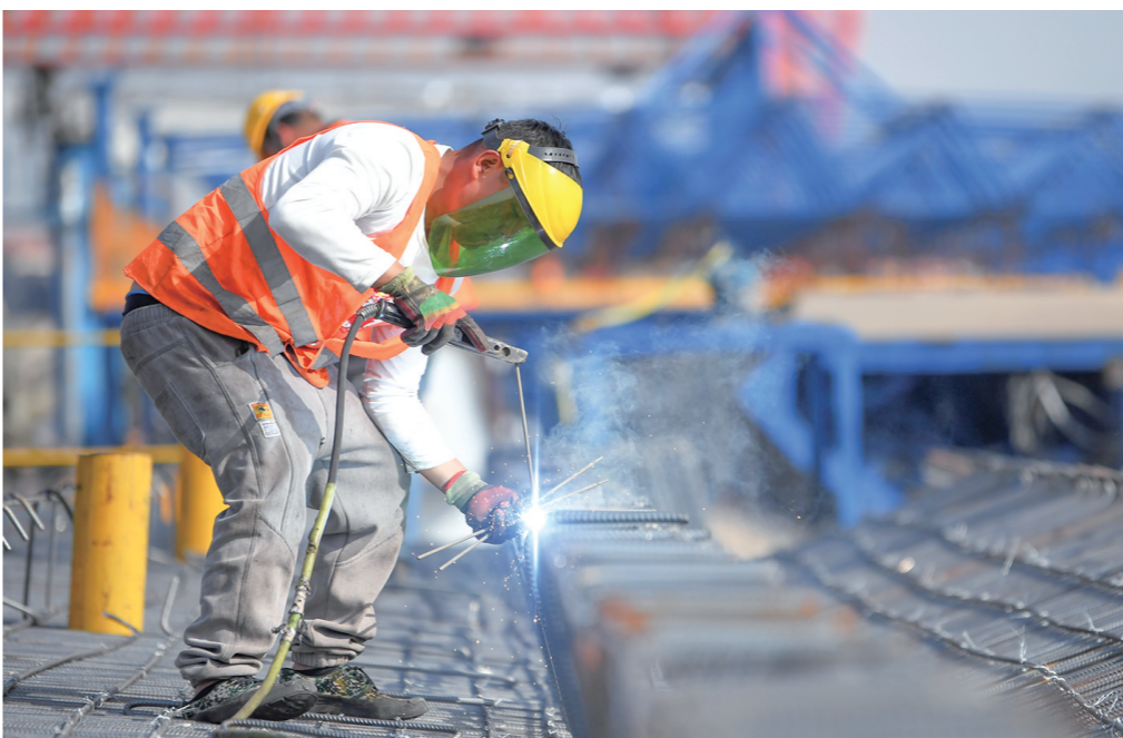
3月20日,施工人员在西十高铁中铁上海工程局蓝田制梁场加工箱梁。
