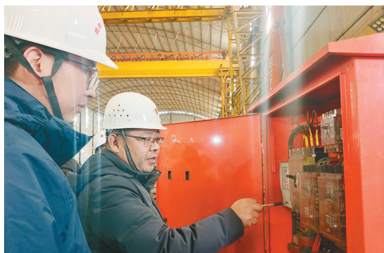
今年以来，中铁十二局集团四公司周转材料中心开展了“手把手”师带徒活动。图为3月22日，一对师徒正进行配电箱安全检查。 □通讯员 王慧春 摄
