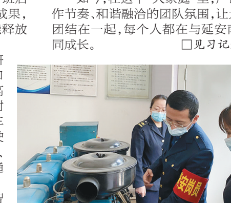
安岗员进行发电机设备安全检查。
