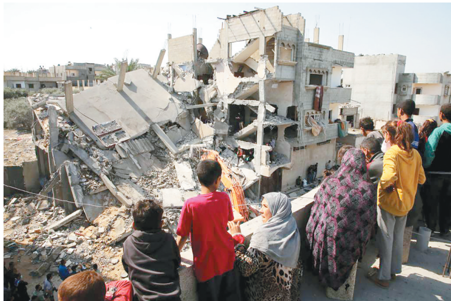
4月2日,在加沙地带南部城市拉法,人们查看被以军空袭后的建筑。 新华社发(哈立德·奥马尔摄)
