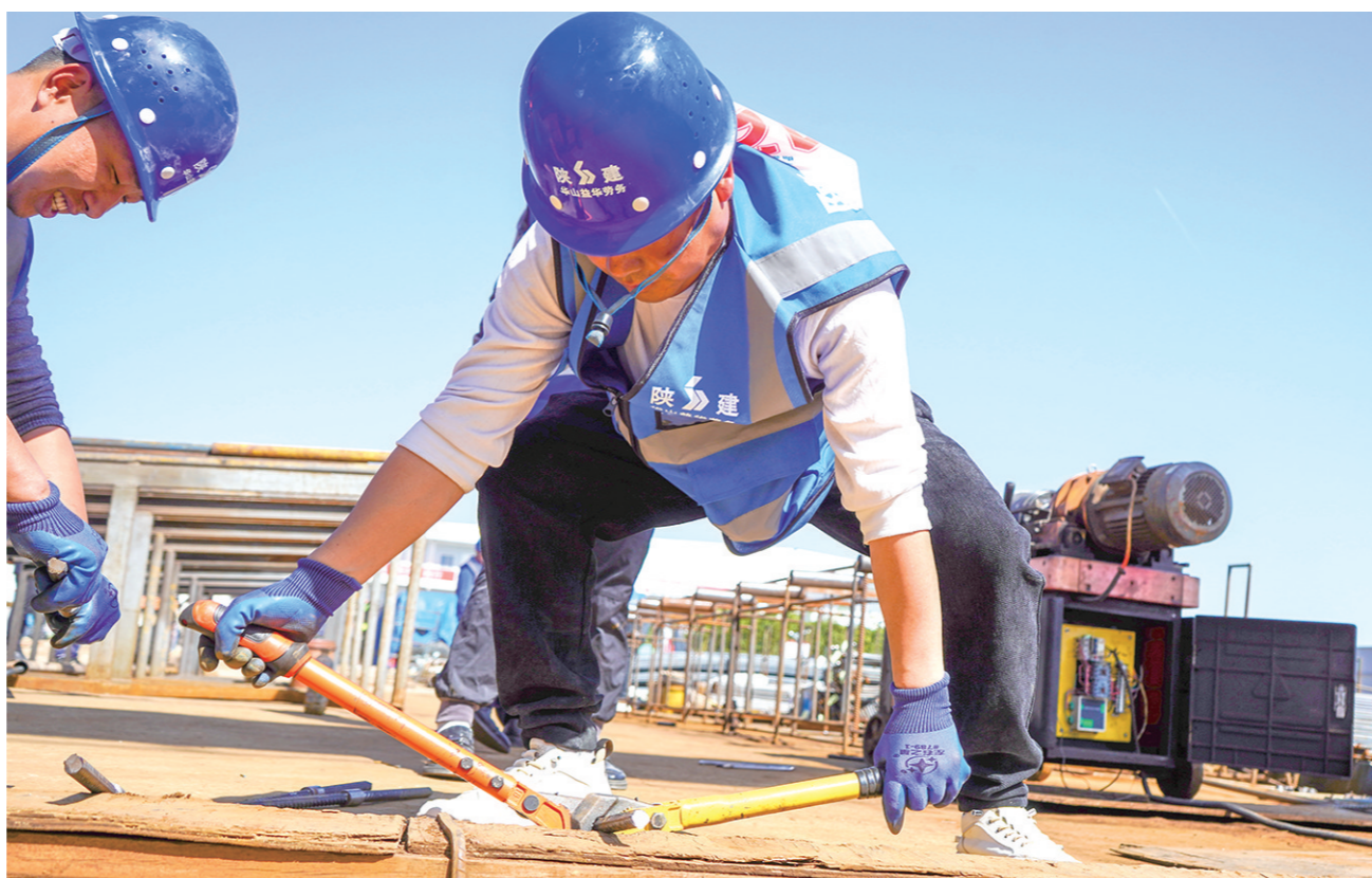
日前,陕建华山劳务集团第二届技能竞赛钢筋工决赛举办,11家单位的36名选手参加。比赛采用理论和实操相结合的方式,选手们沉着冷静,认真答题,精准切割、弯曲、绑扎钢筋,展现出高超的技能水平。 □通讯员 张吉晨 摄
