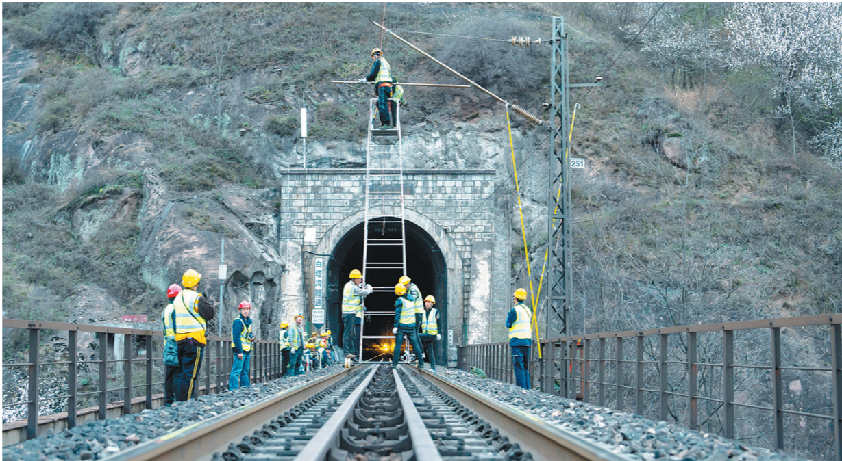
近日，西安铁路局宝鸡供电段组织160余名接触网工，对陇海线福临堡至晁峪区间5锚段白塔沟渭河桥进行更换接触线，开展供电设备大修改造施工，全力提升供电设备质量，保障陇海铁路运输大动脉畅通。 □通讯员 刘一江 李文丰 摄
