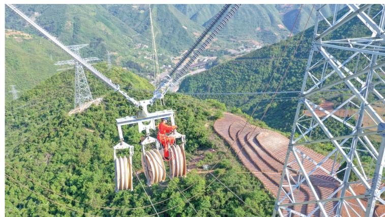
2020年4月27日,电力建设者在青海-河南±800千伏特高压直流工程陕南秦岭段进行架线施工。祝赫 摄
