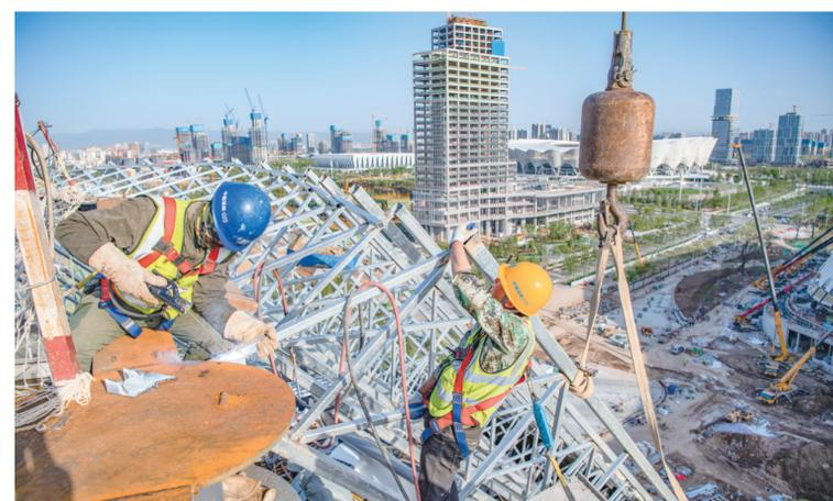
2021年4月28日,在中建三局西北公司承建的“一带一路”文化交流中心系列公建-城市展示中心EPC项目工地,建设者在楼顶焊接网架。袁景智 摄
