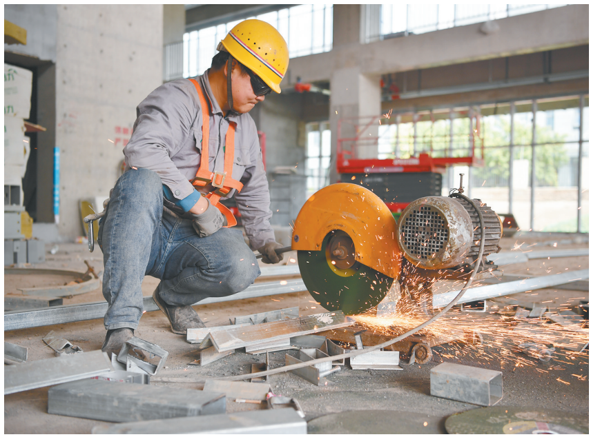
5月1日,工人在中建二局陕西分公司西安航天新材料项目上施工。 新华社记者 邵瑞 摄
