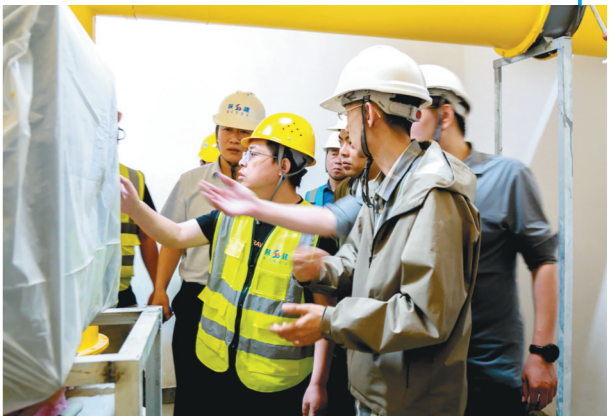
5月9日,西安市国防动员办公室在陕西西安咸阳国际机场三期扩建工程GTC及轨道预留工程项目举办人防工程现场教学活动,普及防灾减灾知识。 通讯员 王向阳 摄
