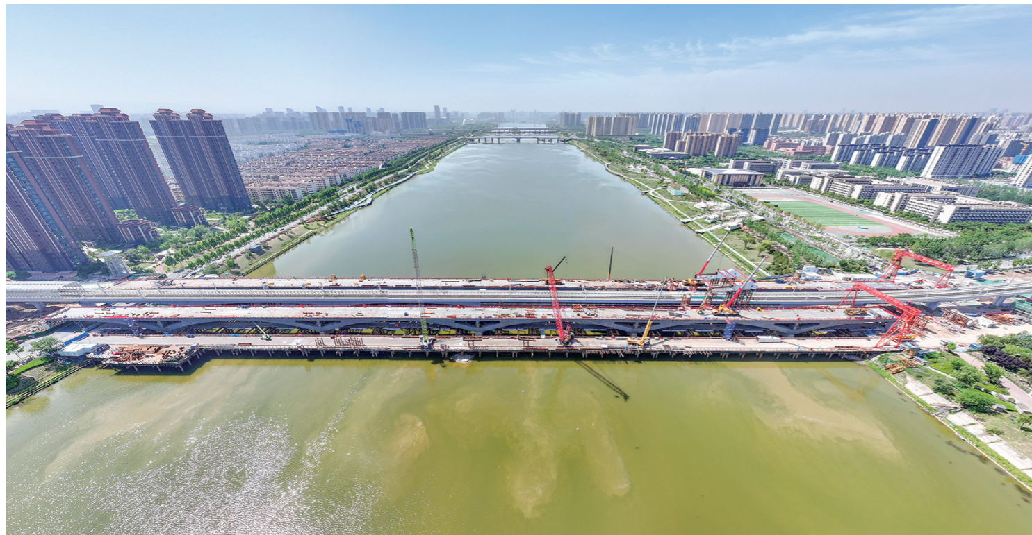
5月14日,建设中的西安国际港务区水流路跨渭河大桥工程项目(无人机拍摄)。项目位于西安市浐灞国家湿地公园以南,渭河口上游约2.5千米处,建设长度1.4千米,地铁10
