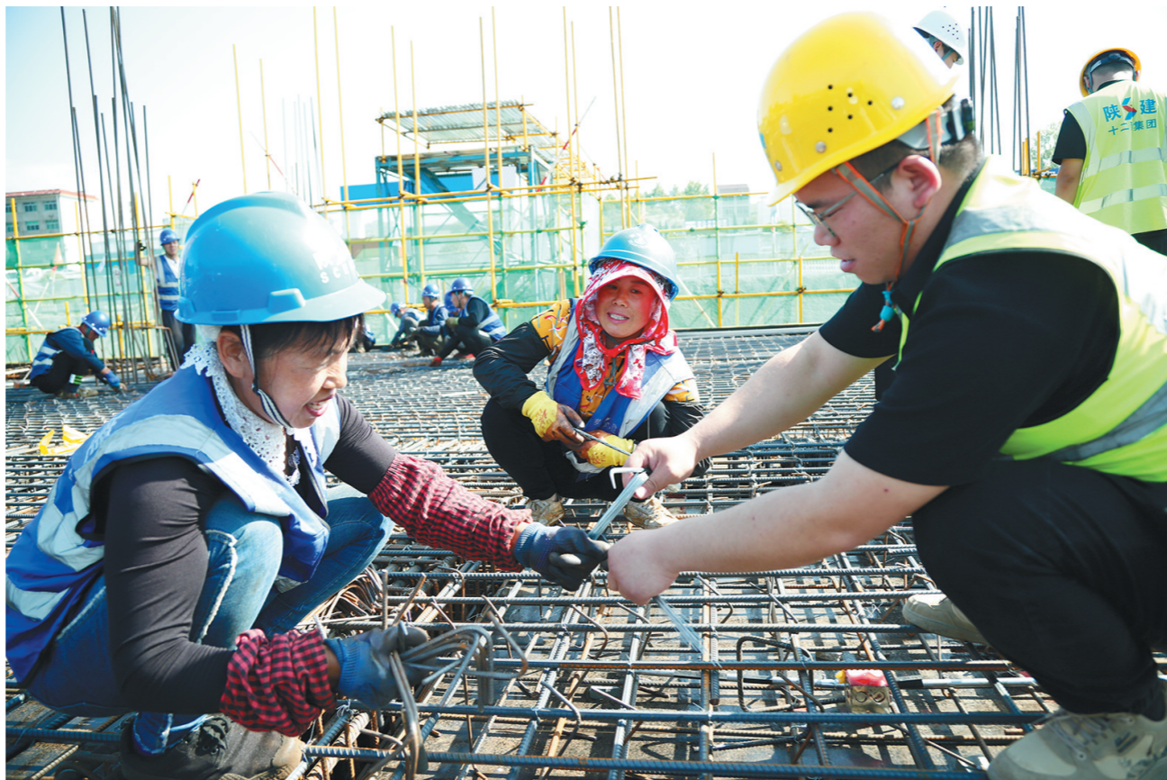
近日,陕建十二建集团一公司组织施工员、质量员在汉阴职教中心项目建设现场学习调直机、弯箍机、钢筋套丝机等机械设备的操作方法与注意事项,并进行钢筋绑扎实训,让建设一线成为实践课堂。
