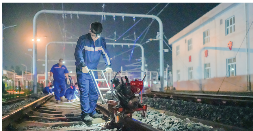
连日来,西安市轨道交通运营分公司轨道专业开展露天区段钢轨更换及轨缝调整作业,保障夏日高温地铁运营安全有序。 通讯员 李嘉彬 摄
