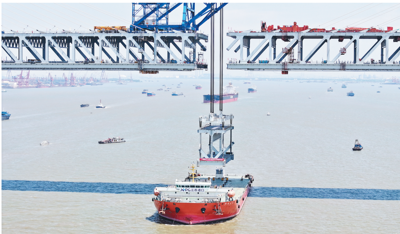
5月29日,随着最后一节钢桁梁顺利吊装到位,中铁宝桥集团有限公司承建的世界最大跨度公铁两用斜拉桥——常泰长江大桥主航道桥合龙段正式拉开了合龙序幕。 □通讯员 邵旭 摄
