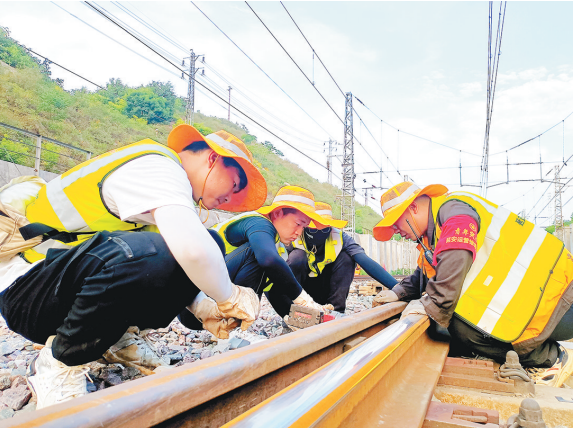
近日,西安铁路局延安运营维修段职工在“北煤南运”大通道浩吉铁路西峡东站内,紧锣密鼓地开展道岔设备隐患排查整治工作,通过调整线路道岔顶铁,及时消除道岔顶铁安全隐患,全力确保道岔设备运行安全,使满载“乌金”的货物列车安全畅通抵达“两湖一江”地区。 □通讯员 赵红伟 摄
