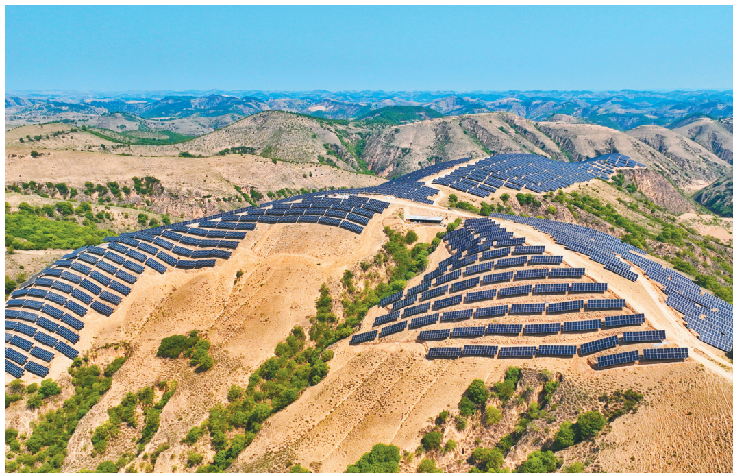
5月28日,航拍位于延安市安塞区的陕煤集团安塞黄矿新能源开发有限公司300兆瓦农光互补光伏发电项目。该项
