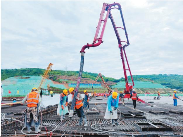
6月4日,参建人员在西安东站高架候车层进行混凝土浇筑作业。(受访者供图)
