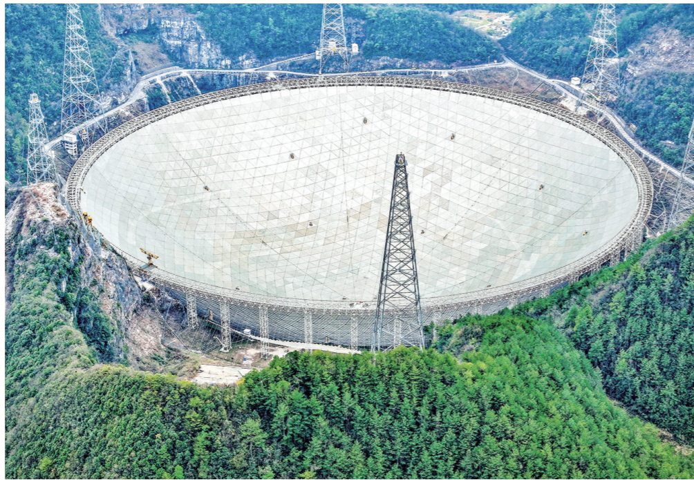
“中国天眼”(无人机全景图片,维护保养期间拍摄)。新华社记者 欧东衢 摄
