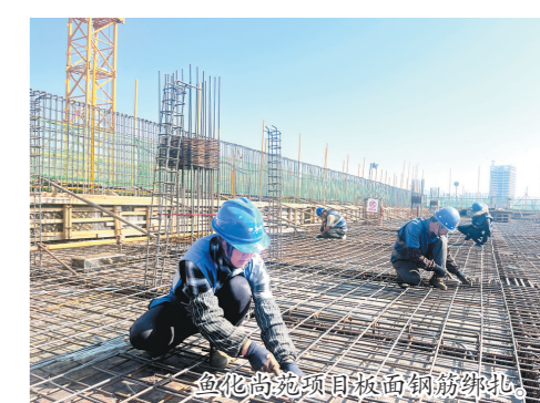
鱼化尚苑项目施工现场
