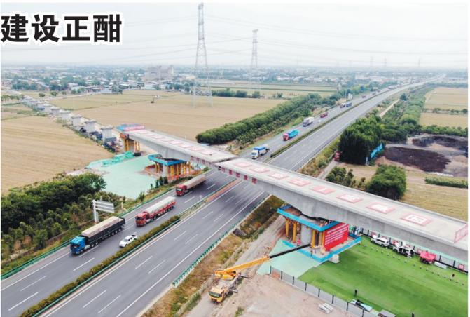
6月28日,中铁十一局集团承建的西延高铁西咸北环线特大桥完成转体对接。当日,经过1小时左右的紧张施工,该特大桥双体同向逆时针旋转66度,两座万吨桥体成功转体对接。 李一博 摄
