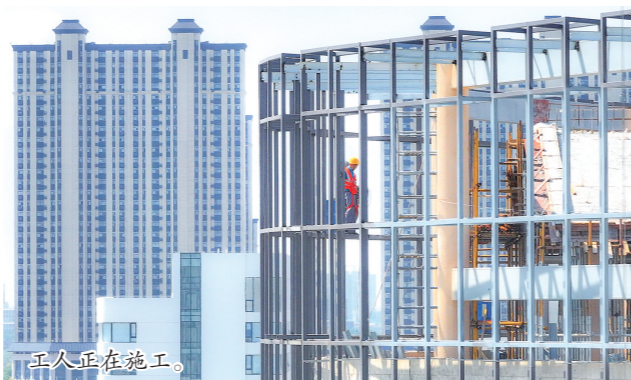
工人正在施工。
