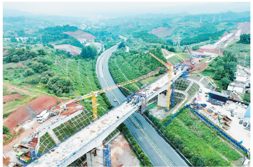
8月16日，由中铁十一局承建的西(安)十(堰)高铁陕西段山阳跨福银高速特大桥合龙，为保障工期顺利推进奠定基础。 新华社记者 张博文 摄
