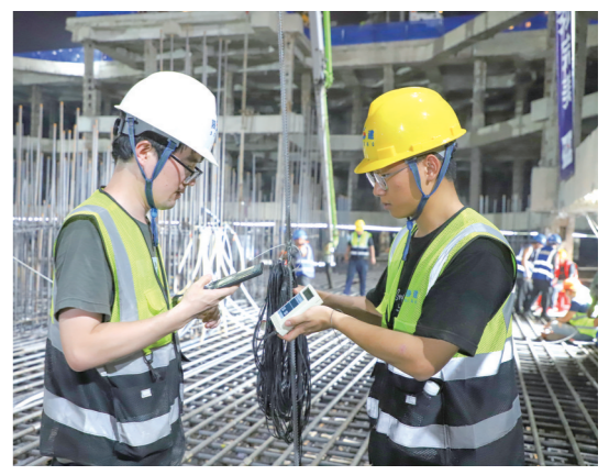
秦强毅(左)测量混凝土温度。
