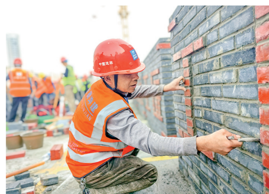
11月8日,由西安市住建局主办的第九届“长安建筑大工匠”职业技能比武开赛。来自全市21家建筑施工企业的95名选手同台竞技,展开砌筑工、钢筋工和抹灰工实操大比武。
