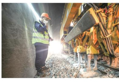
11月7日,西安铁路局安康工务段职工指挥大型养路机械对襄渝铁路新李子溪隧道线路进行捣固作业。为确保陕煤入川大通道安全畅通,该段将利用15个“天窗”完成焊缝精磨、线路捣固等施工任务。 通讯员 张霖 摄
