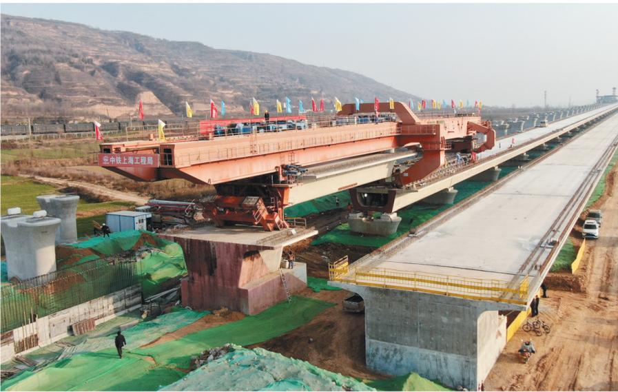
12月25日，中铁上海工程局施工人员操作架设西十高铁西安方向最后一孔箱梁（无人机照片）。
