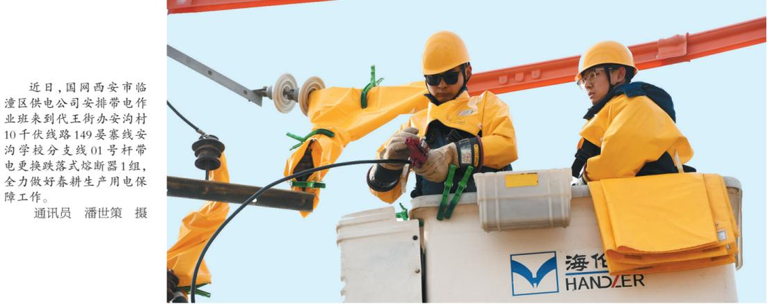
近日,国网西安市临潼区供电公司安排带电作业班来到代王街办安沟村10千伏线路149号寨线安沟学校分支线01号杆带电更换跌落式熔断器1组,全力做好春耕生产用电保障工作。通讯员 潘世策 摄
