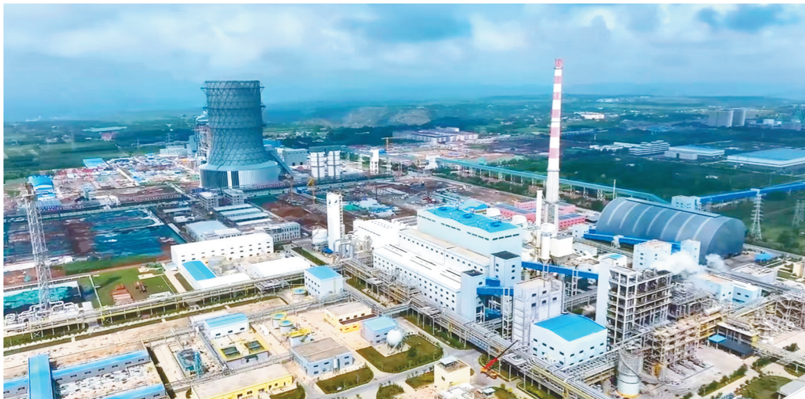
这是位于咸阳(彬州)高端能源化工园区内的彬长660兆瓦超超临界循环流化床发电项目(2024年10月1日摄)。
